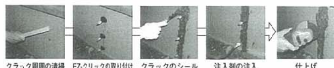
クラック周囲の清掃 EZ-クリックの取り付け クラックのシール 注入剤の注入 仕上げ
